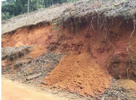
Figura 54 – Estaca 317+0,00 – LE – Retaludar – Área de Empréstimo 02
