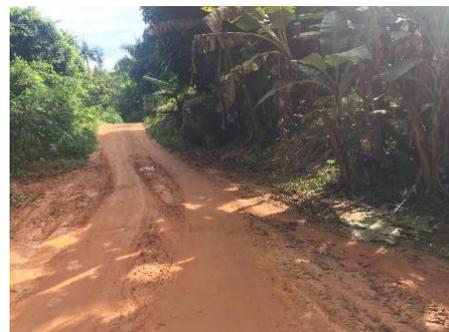
Figura 41 – Estaca 13+0,00 – Rocha 0 Levantar Greide para fazer caixa LD
