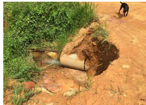
Figura 51 – Estaca 174,00 - Erosão Bueiro LE
