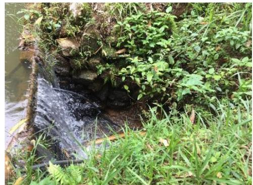
Figura 49 - Estaca 99+0,00 Erosão LD - Vertedouro
