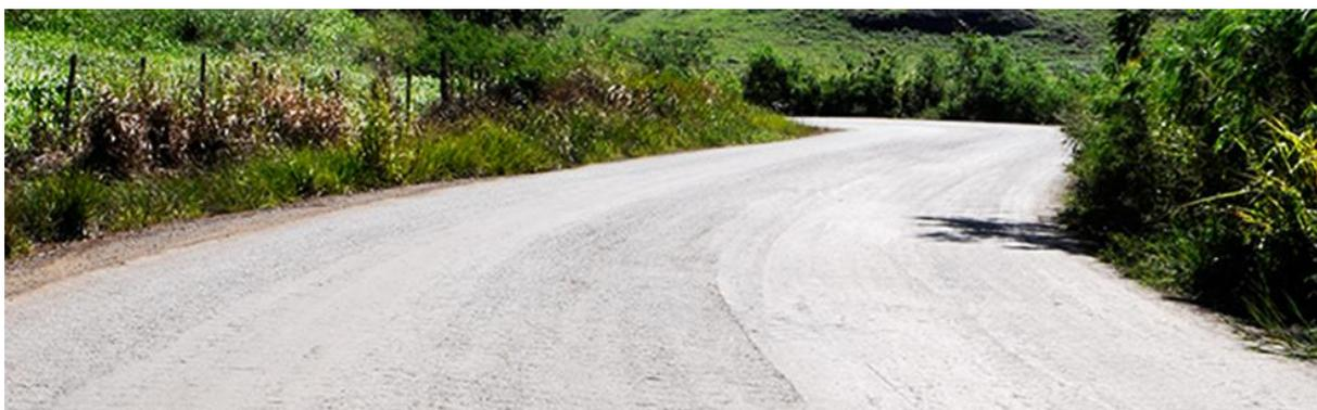
Figura 188 – Estrada rural com revestimento primário do tipo Revsol.
