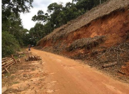
Figura 55 – Estaca 317+0,00 – LE – Retaludar – Área
