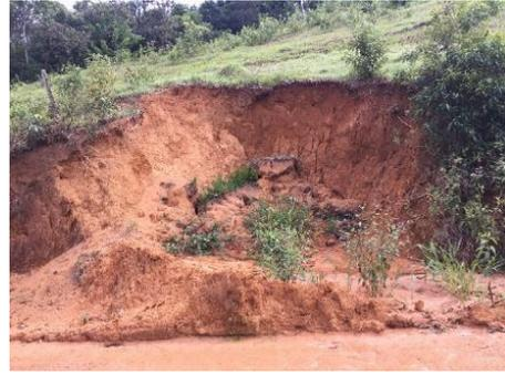
Figura 53 – Estaca 317+0,00 – LE – Retaludar – Área de Empréstimo
